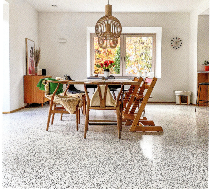
Terrazzoboden muss nicht kalt sein: »Via Terrazzo« lässt sich über einer Elektroheizung auftragen.
