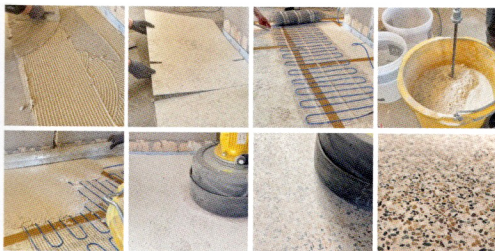
Die Terrazzo-Fließspachtelmasse wird mit einer Kelle auf der Heizung aufgetragen und anschließend abgeschliffen.
